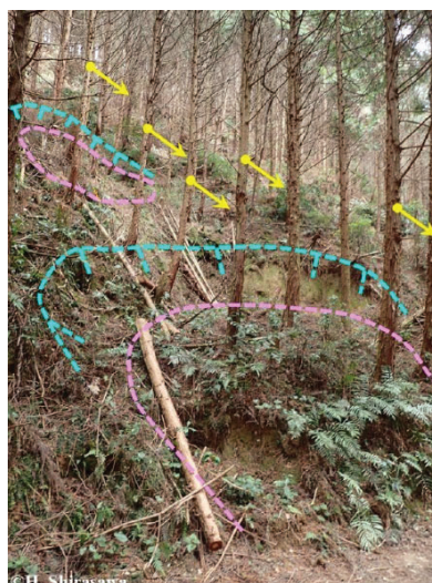
図34 表層クリープ(移動体)と立木の変状の例
